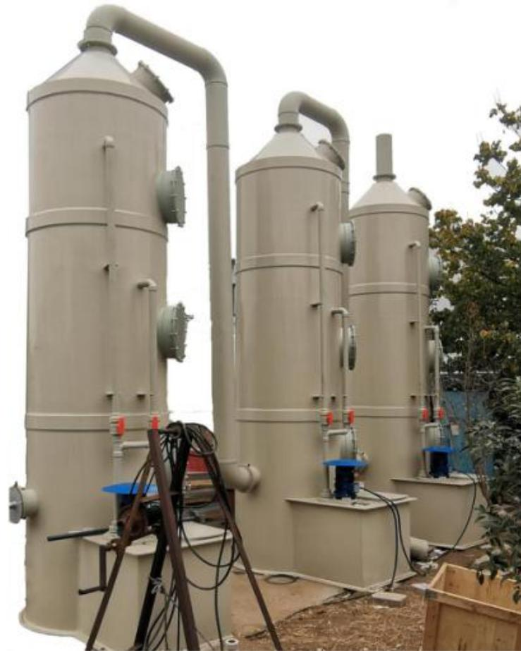
图 4-2 三级酸雾净化塔处理工艺图
